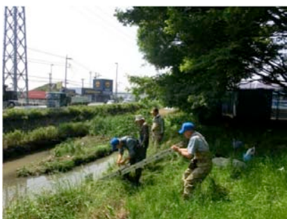
崖下へのはしご設置作業中
