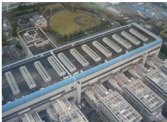
緑化率が 40%を超えている火力発電所の俯瞰写真
