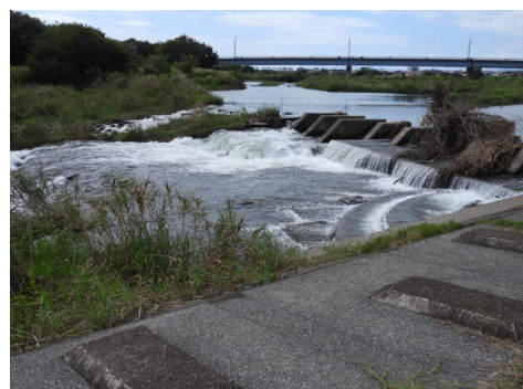
川越橋下流 浅間堰 手前半円形が魚道
