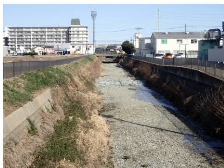
現在は直線化されたコンク リート護岸 冬場は水がない
