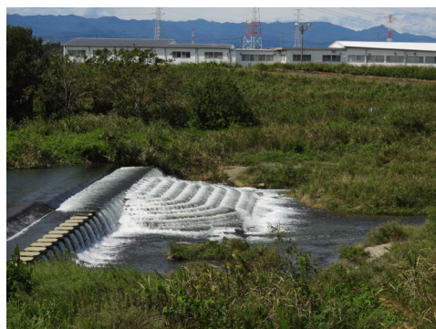
寺山堰 階段状円形魚道
