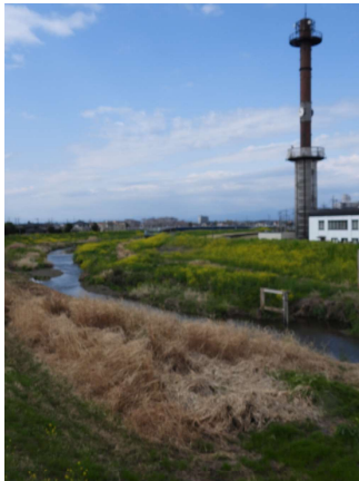
荒川上流河川事務所の河川水位監視塔
