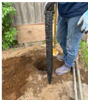
②杭打ち: 長さ60cmの「焼杭」を打ち込み、浸透の拠点とします。
