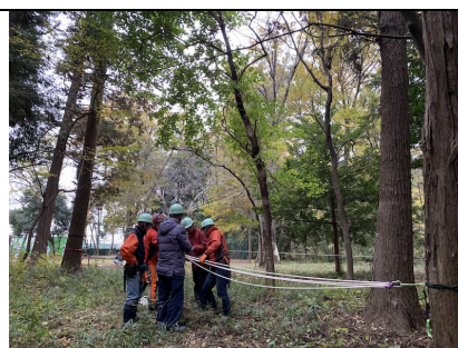
ロープワークでコナラの枯損木を伐倒する準備
