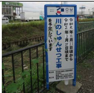
工事開始の立て看板
