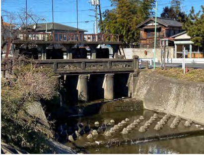
田谷堰 (下流側・新赤間川)
