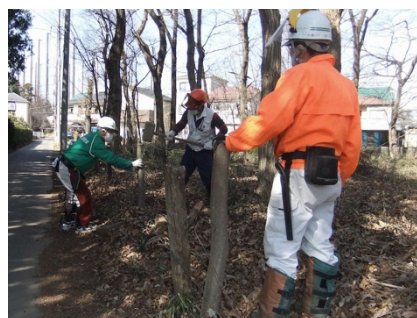
間伐材を使った杭打ちの様子
