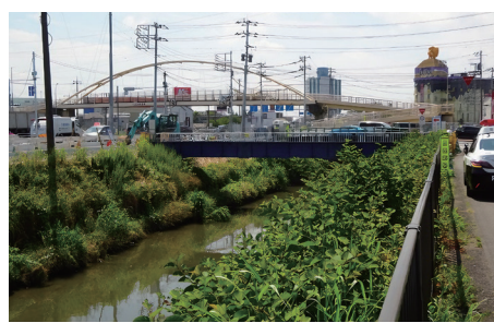
新河岸川新琵琶橋から下流（6月15日） 橋梁工事中、水量は普段と変わらない
