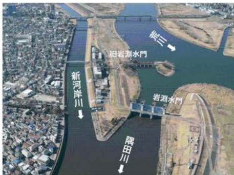
岩淵水門付近 (出典：関東地方整備局ホームページ)
