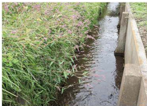
水路にはきれいな水が流れる
