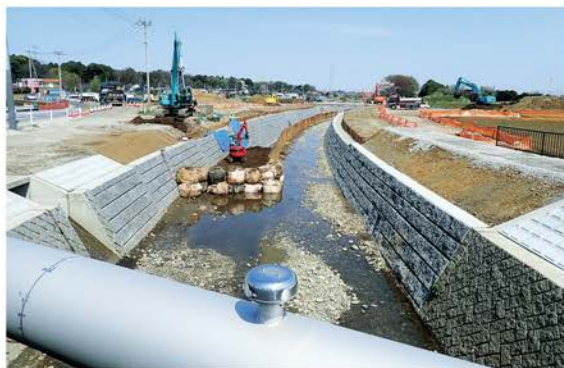
中福付近の改修工事
