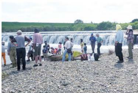
寺山堰 魚道設置前 (2013年)
