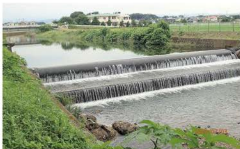
田谷橋のラバー堰
