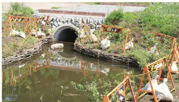
完成当初の池と水路 粗朶工法
