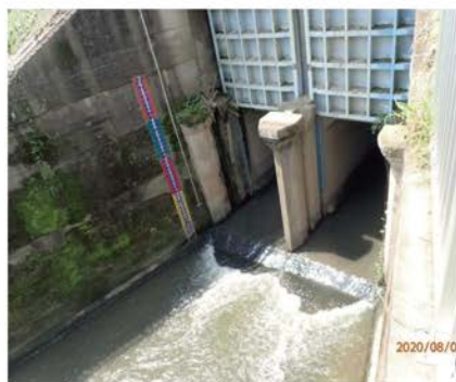
古谷樋管（水門）
